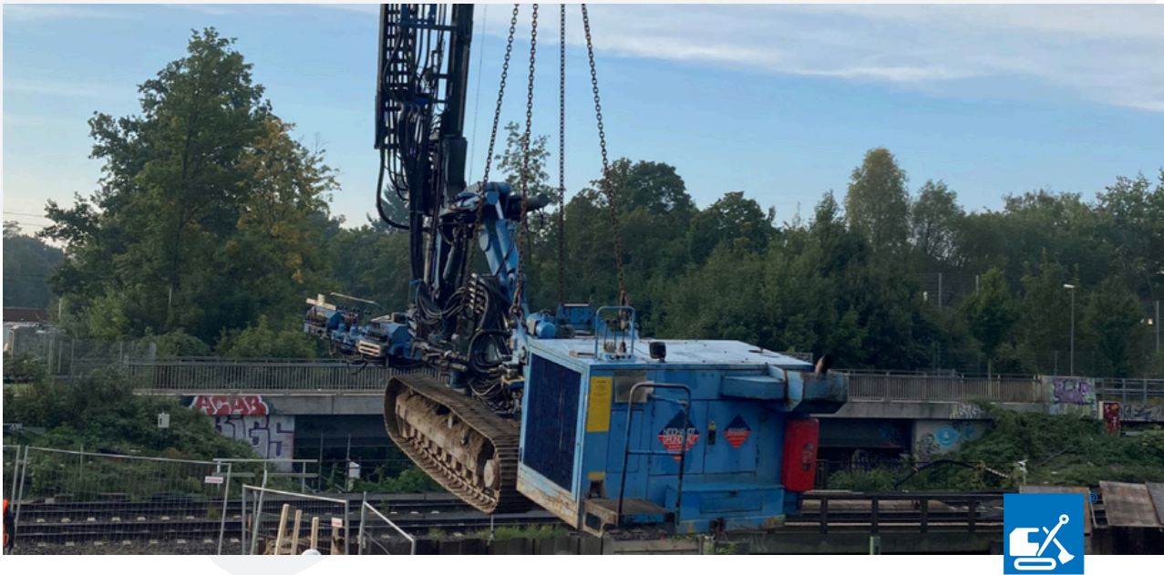
Abb. 1+2. Kraneinsatz zum Einhub des Bohrgeräts . Fotograf: Lorenz Dörwald.
