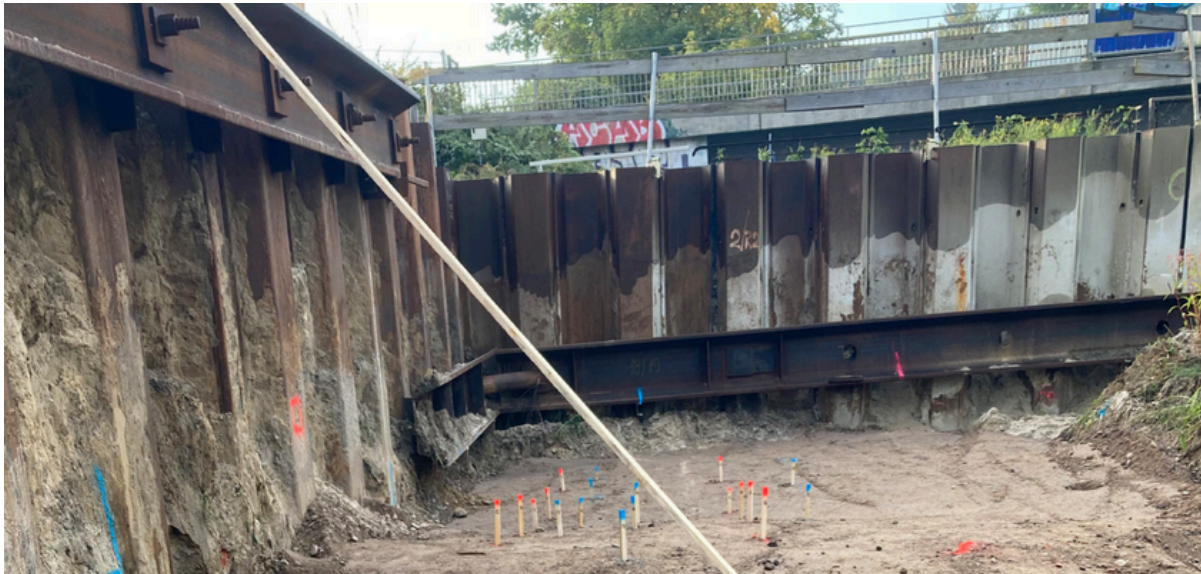
Abb. 3 .. Baugrube mit Markierungen. Fotograf: Lorenz Dörwald.
