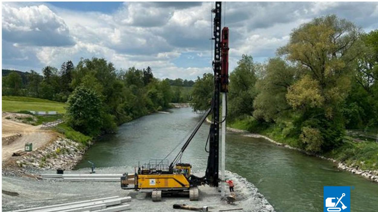
Im Rahmen des Brückenbauprojekts an der Iller wurden insgesamt 150 Fertigpfähle mit einem Querschnitt von  $35 \times 35$  cm verbaut. Die Pfähle sind jeweils zweifach gekuppelt und erreichen dadurch eine Gesamtlänge von rund 31 m. Die Gründung erfolgt im weichen Seeton, was eine entsprechend sorgfältige Ausführung sowie eine angepasste Bemessung erforderlich macht.
